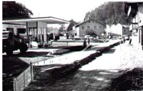
Straßenbau in der Wasserburger Straße
