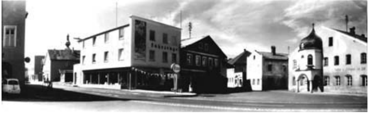
Der Marktplatz nach dem Straßenbau
