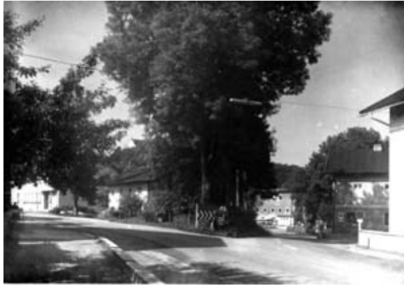
Einmündung der Bahnhofstraße in die Hauptstraße vor dem Straßenbau
