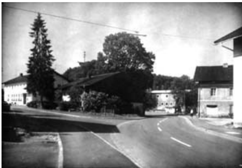
Nach dem Straßenbau
