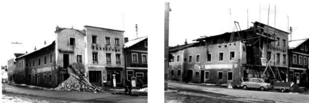
Abbruch des Schönlinnerhauses Hauptstraße 58
