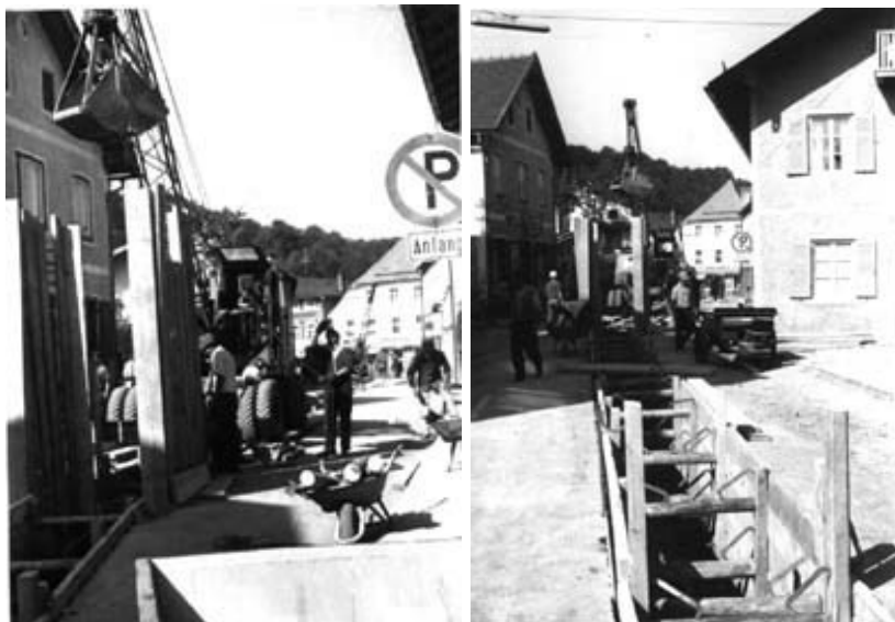
Altenmarkt während der Kanalbauarbeiten im September 1961
